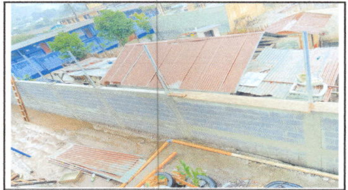
Foto 4: sustitución de muro de lamina por muro de block
